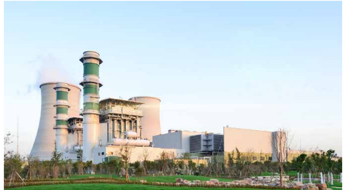
打造“花园式”燃机电厂,提升生态环保治理水平
