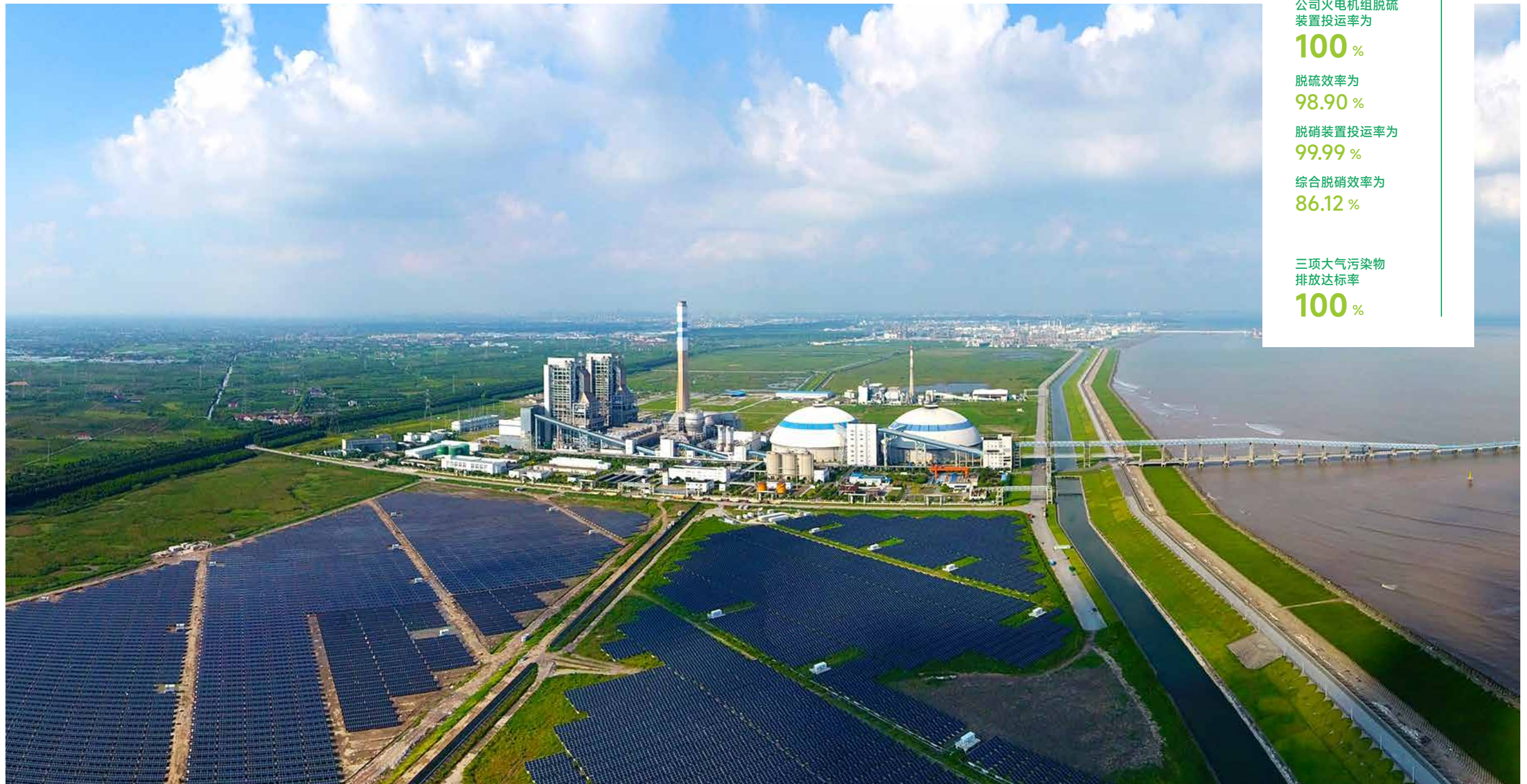
漕泾电厂厂区周边可移动式光伏
