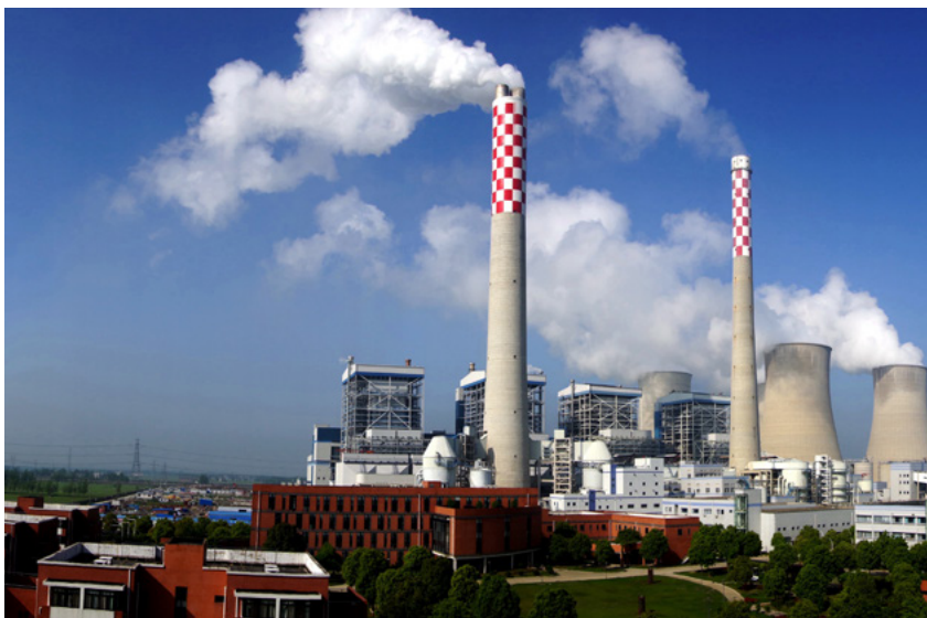
田集电厂全景
