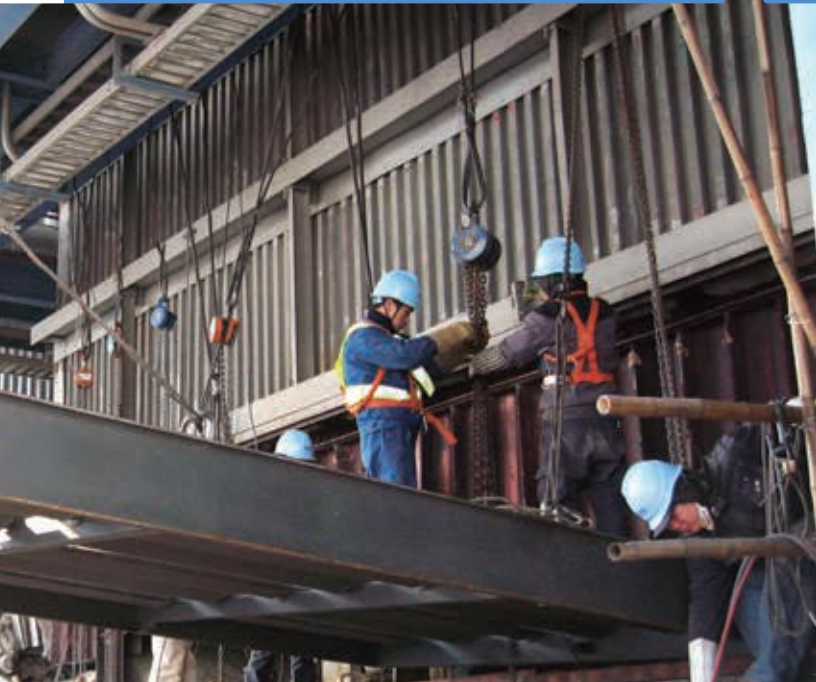
▲ 改造工程施工现场
