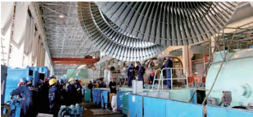
▲ 外高桥大修现场
