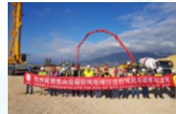
黑山项目首台风机基础浇注
